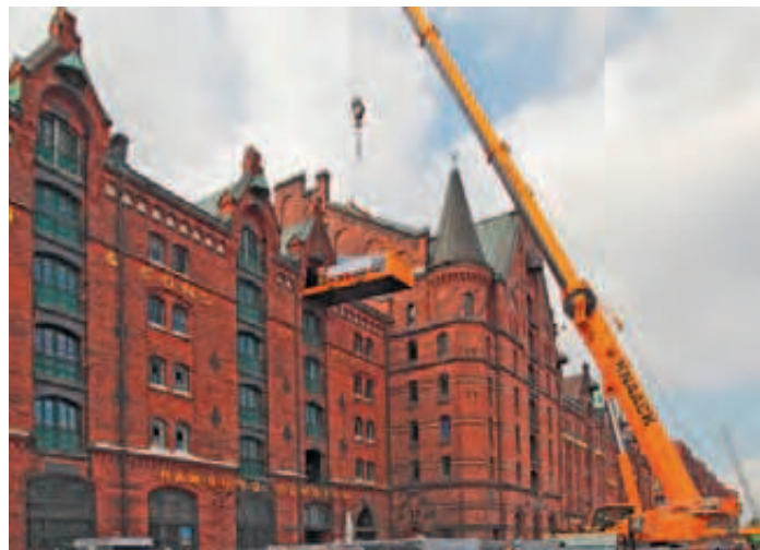
Einbringung der Kälteanlage durch die Dachgaube
