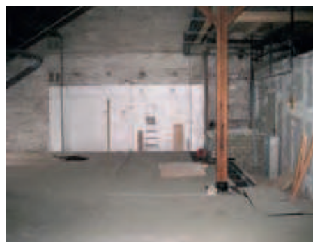
Der mit Stahlträgern ausgelegte Dachboden
