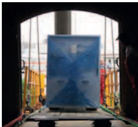
Kältemaschine vor der Gaube
