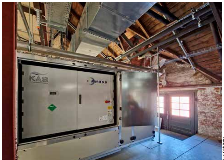
Schaltschrank der Kältemaschine Typ TCHITL 1600
