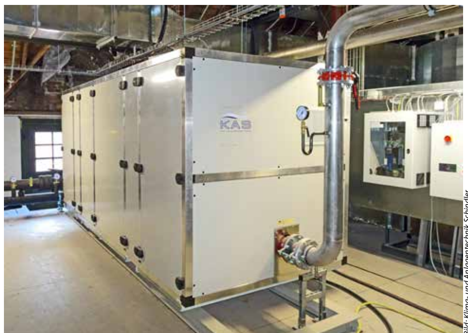
Kältemaschine (600 kW Kälteleistung) mit geschlossener Schallschutzverkleidung
