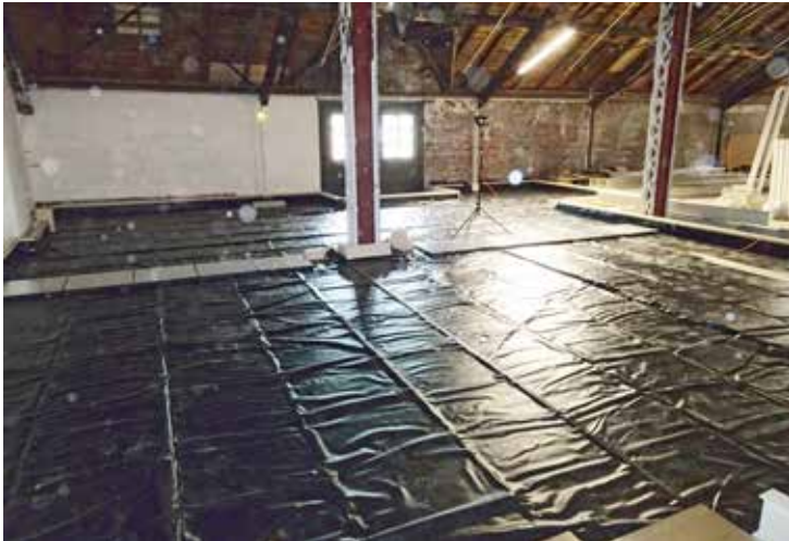
Bild: Klima- und Anlagentechnik Schindler
